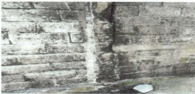
Foto 5: Reparación de muro perimetral
