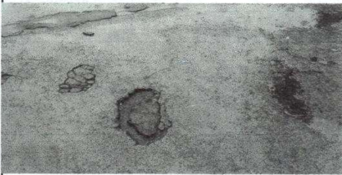
Foto 1: Estado actual del patio
