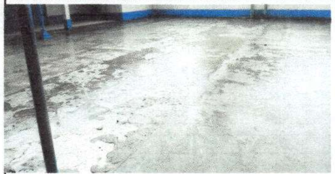
Foto 2: Estado actual del patio.
